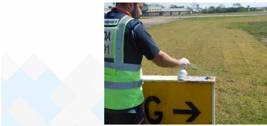
Figura 10 – Funcionário aplicando produto repelente em placa de sinalização
