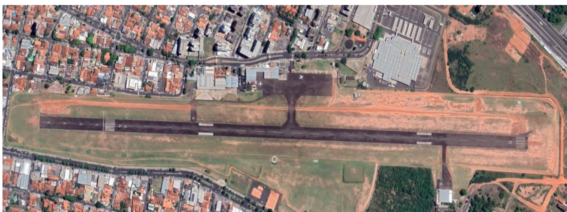
Figura 5 – Vista aérea do Aeroporto de Bauru
