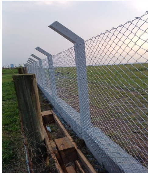
Figura 5 - Finalização da implantação do novo sistema de barreira de segurança no aeroporto de Lages, antes da remoção dos palanques de madeira e cerca de arame farpado
